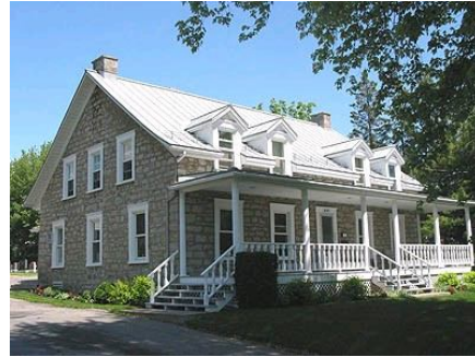
Presbytère de la paroisse Saint-Raphaël-Archange. Photo Jean-François Rodrique, 2004.
